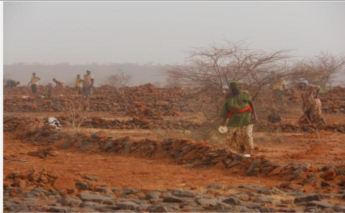
**Photo 1 :** Ouvrage de freinage du ruissellement des eaux de pluie sur plateau réalisé par les femmes
